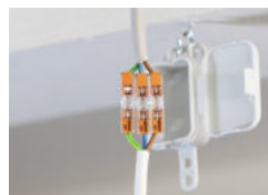
Leuchtenanschluss in Zwischendecken
